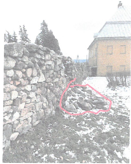
Stan zachowania obiektu przed konserwacją , poszczególne elementy wstępu ruchome . Na ziemi widoczny fragment zawalonego muru .
