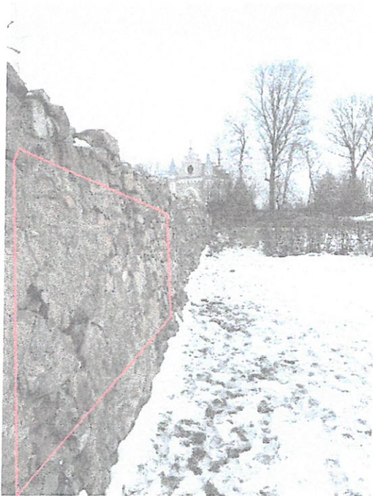
Na fotografii widoczne fragmenty cementowych tynków.
