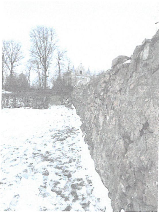
Widoczne doraźne uzupełnienia muru cegłą i zaprawą cementową.
