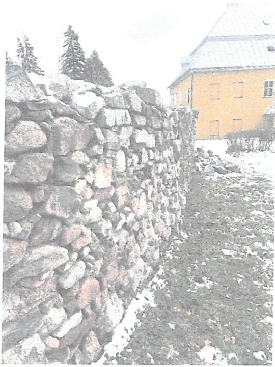
Stan zachowania obiektu przed konserwacją , poszczególne elementy wstępu ruchome . Na ziemi widoczny fragment zawalonego muru .
