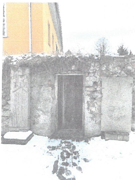
Widoczne wadliwe uzupełnienia muru spoinowane zaprawą cementową.
