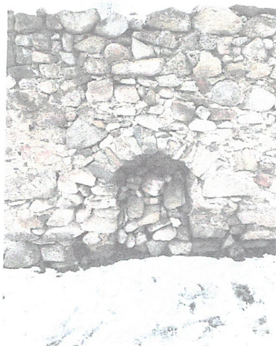
Widoczne wadliwe uzupełnienia muru spoinowane zaprawą cementową.
