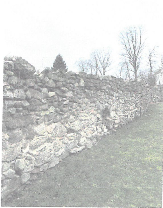
Stan zachowania obiektu , mur od strony zewnętrznej kościoła 2023 r. widoczny brak spoin , zwłaszcza w górnych i dolnych partiach muru. Widoczne spoiny z szarej, cementowej zaprawy .
