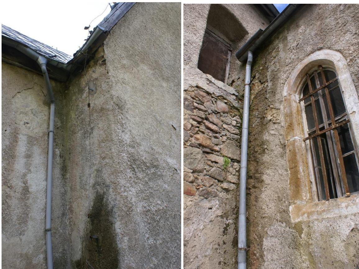
Zdjęcie nr 8,9 – Widok fragmentów elewacji z widocznymi zawilgoceniami spowodowanymi zdegradowanymi rynnami i rurami spustowymi.
