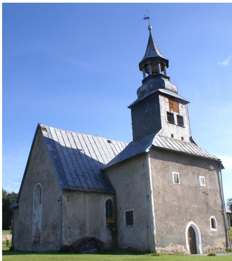
Zdjęcie nr 2 – Widok obiektu od strony południowo-zachodniej widoczne rdzawe zacieki na pokryciu oraz zawilgoconą ścianę na skutek uszkodzonego orynnowania.
