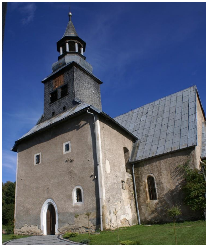
Zdjęcie nr 1 – Widok obiektu od strony południowo-wschodniej widoczne rdzawe zacieki na pokryciu oraz uszkodzoną ścianę na skutek uszkodzonego orynnowania.
