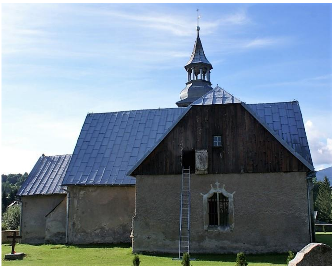
Zdjęcie nr 3 – Widok obiektu od strony północnej widoczne zawilgocenie ściany w strefie przygruntowej
