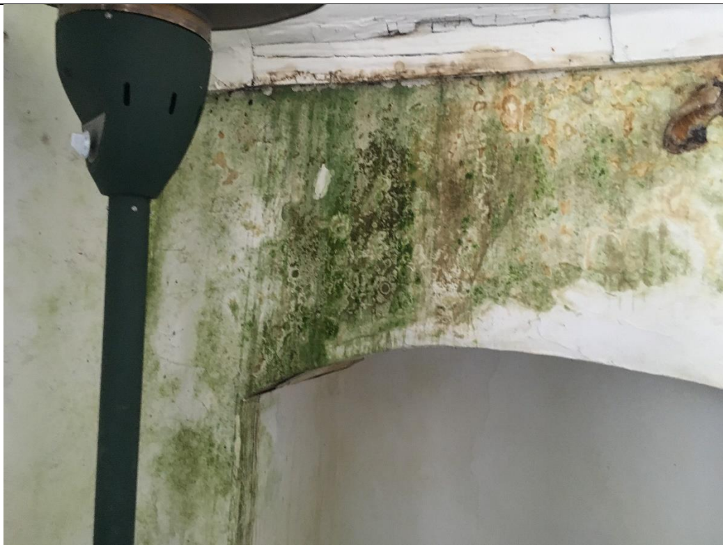
Zdjęcie nr 10 – Fragment ściany pod chórem – widoczne wykwity glonów i grzybów
