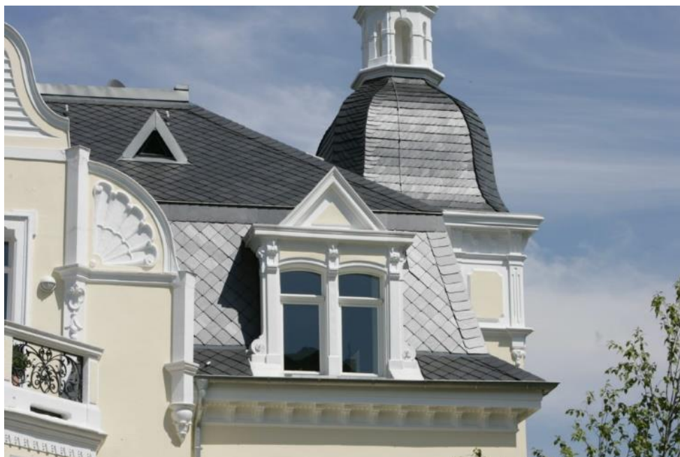
Fot. 3 Fragment dachu z zastosowaniem zaprojektowanego krycia ostrokątnego "francuskiego" oraz niemieckiego na fragmencie wieży
