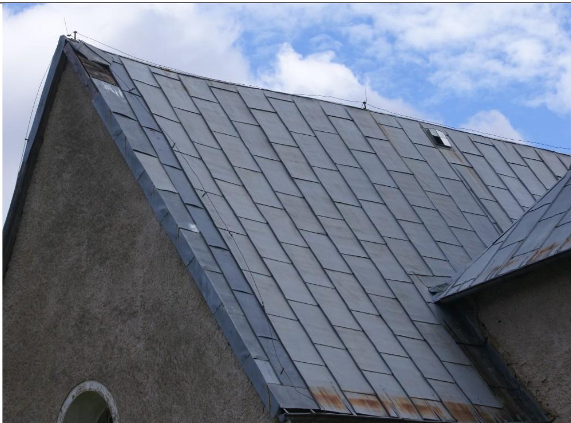
Zdjęcie nr 5 – Stan zachowania pokrycia dachu widoczna korozja pokrycia dachowego oraz ubytki w poszyciu dachu .
