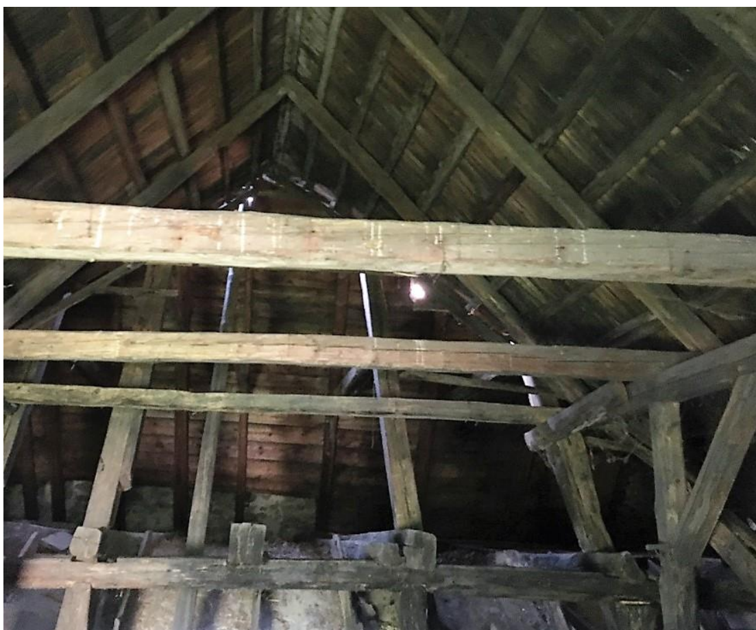
Zdjęcie nr 6 – Widoczny stan zachowania deskowania połaci południowej oraz elementów konstrukcji dachu
