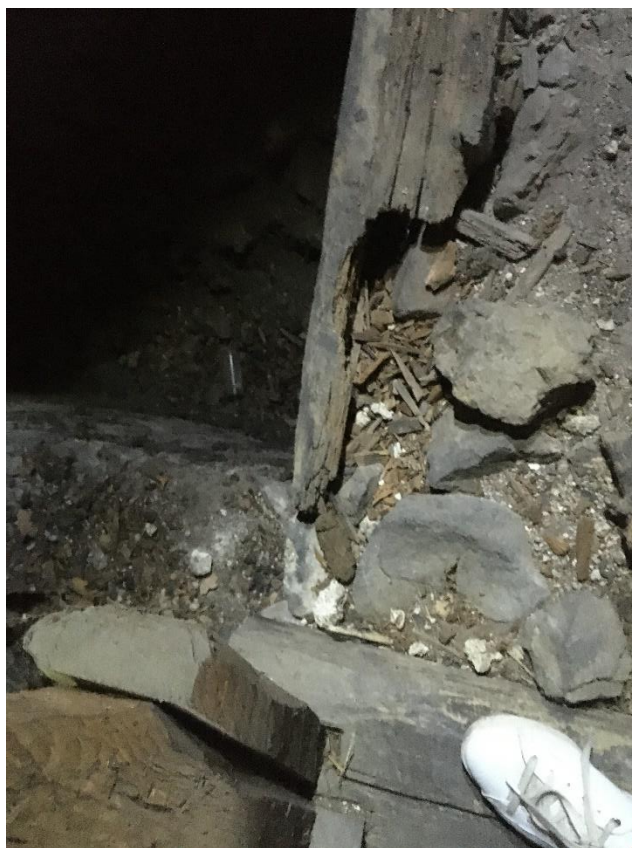
Fot. 7 widoczny fragment przegnitej belki stropowej nad nawą główną
