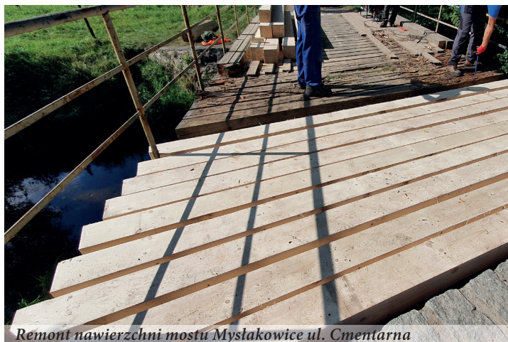
Remont nawierzchni mostu Myślakowice ul. Cmentarna
