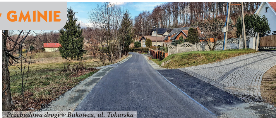
Przebudowa drogi w Bukowcu, ul. Tokarska
