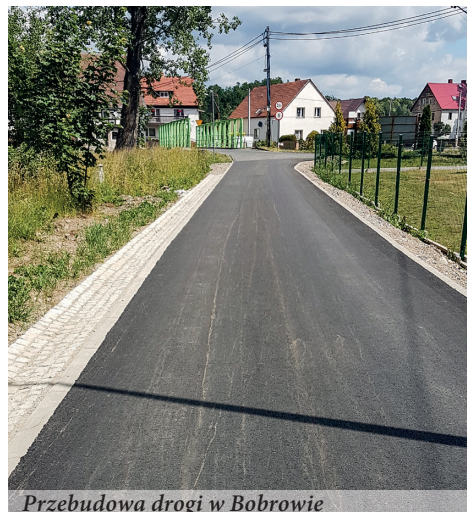
Przebudowa drogi w Bobrowie
